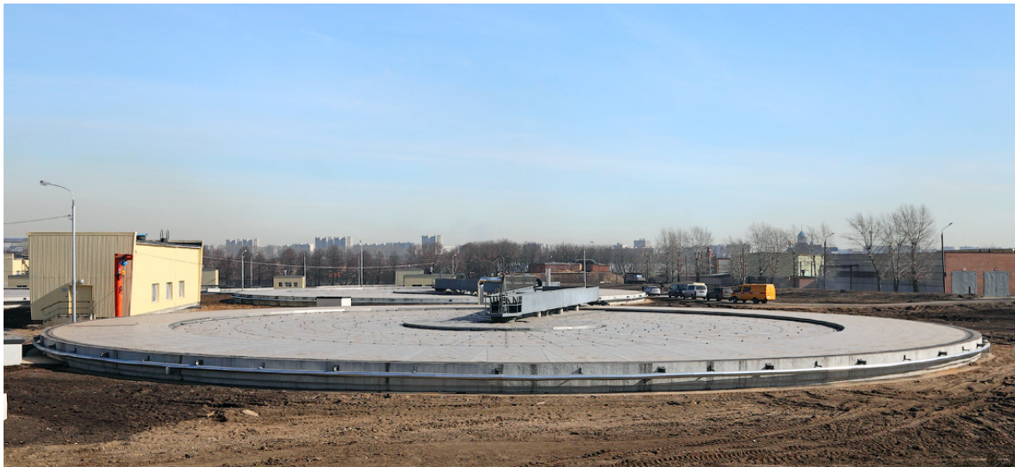
Рис. 2. Плавающее перекрытие на первичном отстойнике
