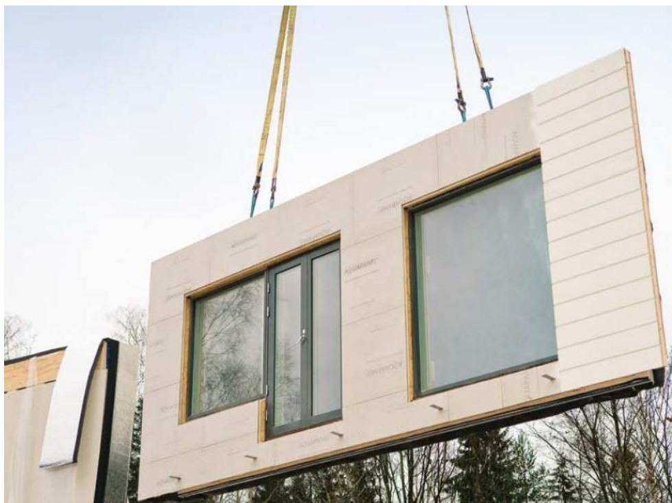
Рис 3. Доставка готовой CLT-панели на строительную площадку
